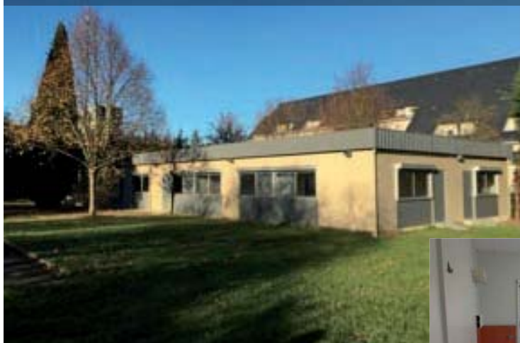
Extérieure de la nouvelle plateforme
